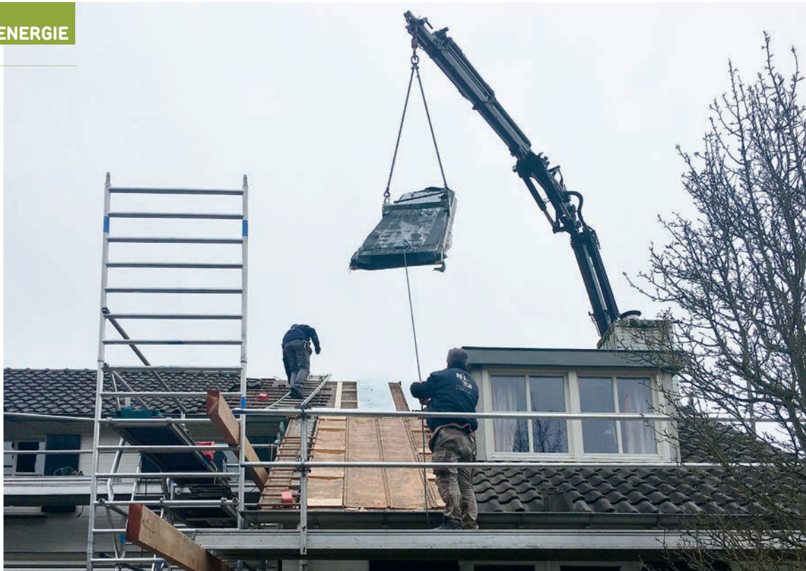
Inhijzen van een reeds in de bedrijfshal van SolarTech geheel voorbereid dakpaneel.
